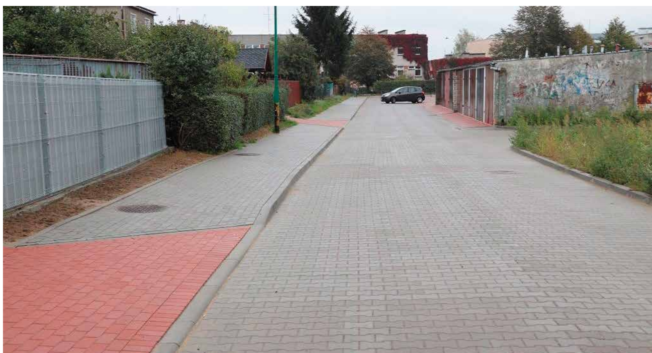
Ulica po remoncie
