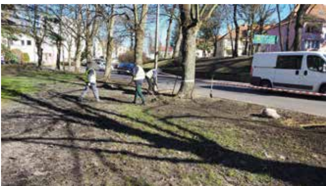
Zieleńce - ul. Zielona, ul. Osiedlowa
